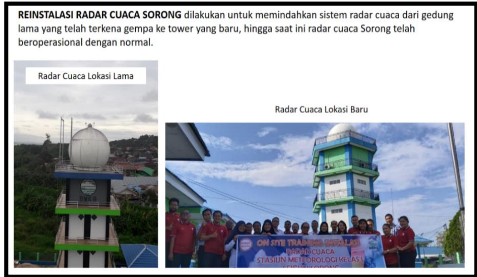
Gambar 1.7 Kegiatan Bidang Meteorologi terkait Pemasangan Radar Cuaca
